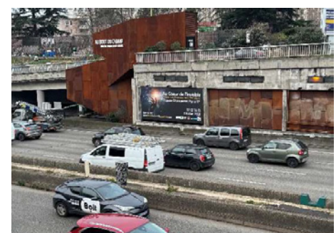
Bache de 6m sur le Périphérique
